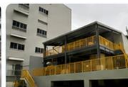
廢水處理設施
